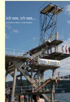
Sprungturm Müllstättersee, ohne und mit Stahllaufbau anlässlich ... Foto: DI Peter Nigst
