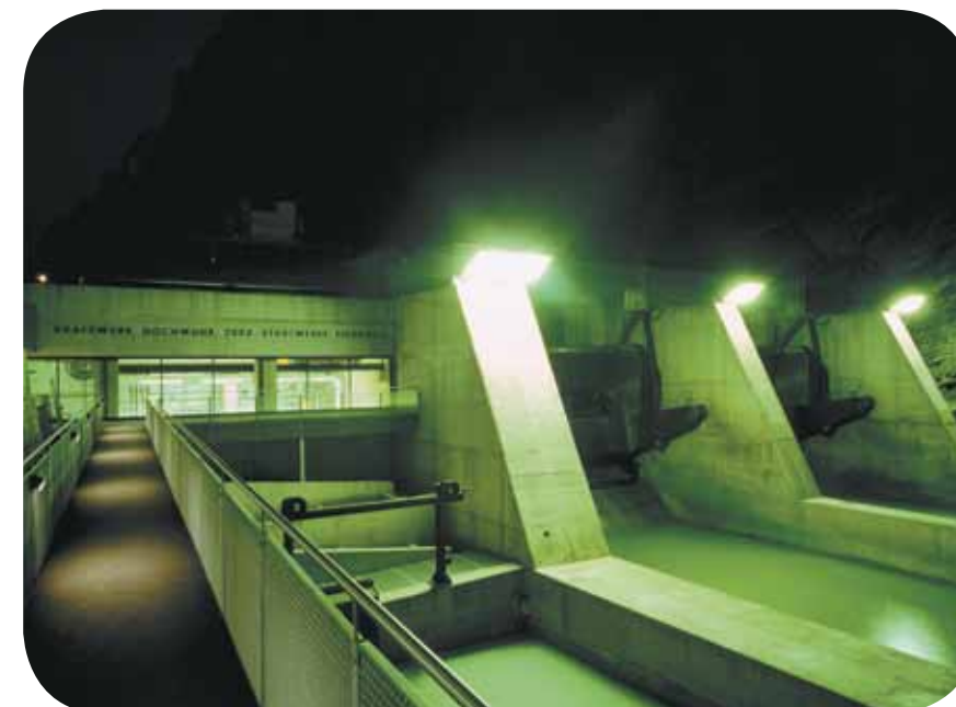
Hydrokraftwerk Hochwuh, 2004, Artec Architekten, Foto: marclins.com
