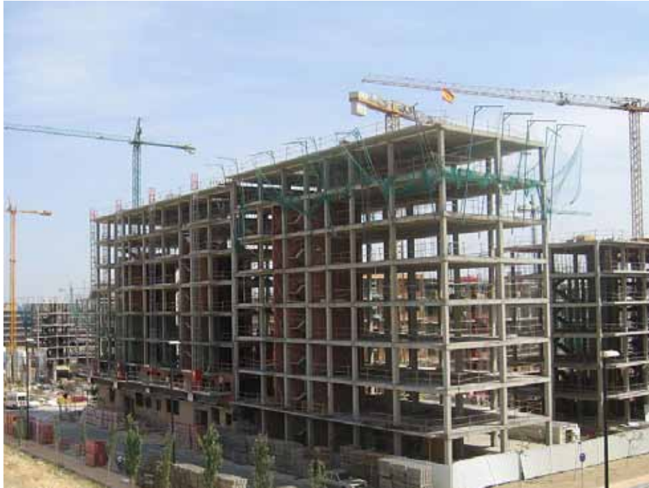
Stahlbetonskelettbau, Baustelle in Spanien
