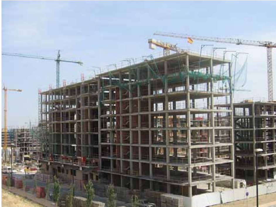
Stahlbetonskelettbau, Baustelle in Spanien
