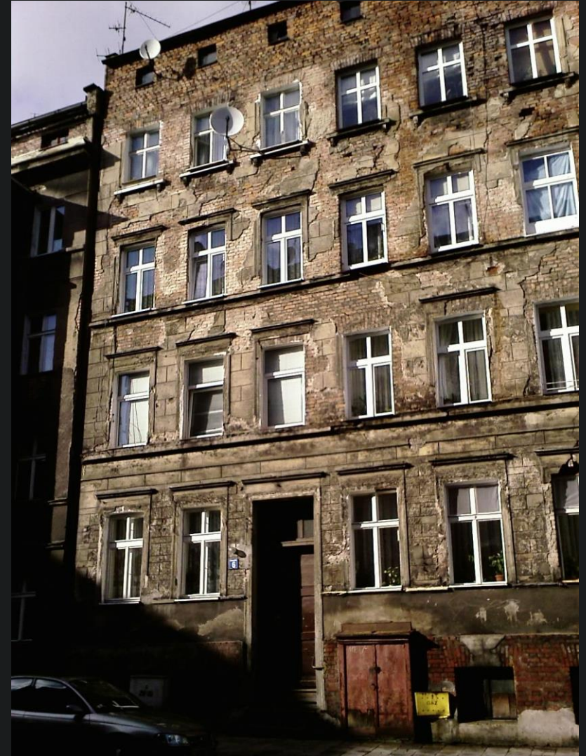
Verputztes Ziegelmauerwerk einer Miets-/Zinskaserne in Berlin Quelle: https://sites.google.com/site/ruszkowskijuergen/kindheit
