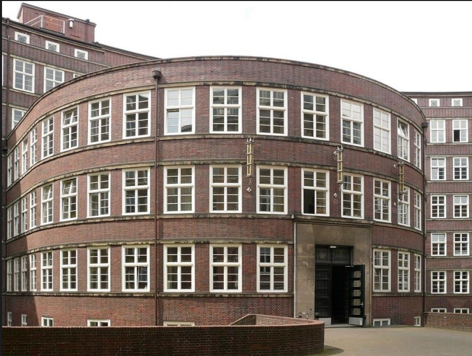
GRUNDBUCHHALLE VON FRITZ SCHUMACHER in HAMBURG
