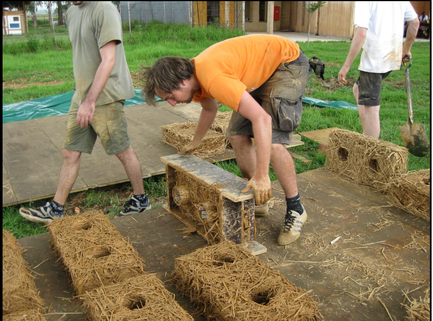
Ausschalen und anschließend Trocknungsprozess
