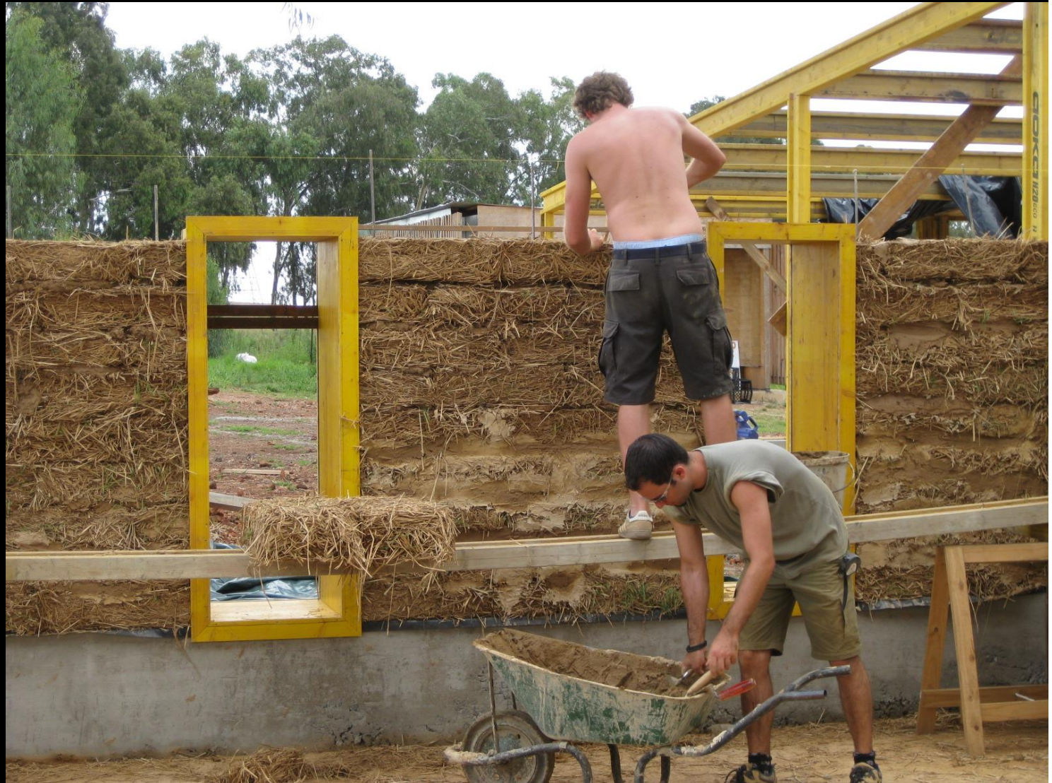
Aufbau der Strohlehmziegelwände zwischen den kastenähnlichen Fensterumrahmungen
